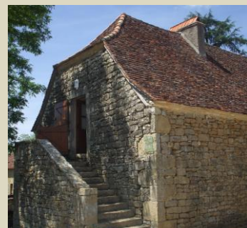
Le bâtiment de l'Association à Salgues Salle « Michel Doumerc »
